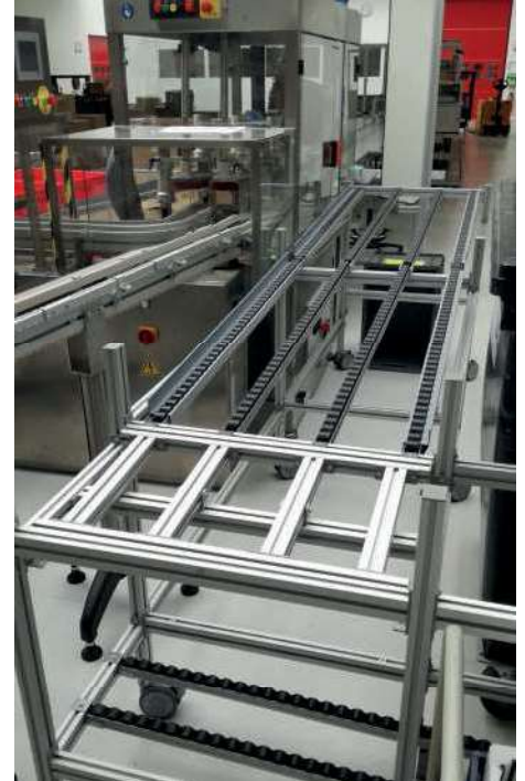
Evacuation des emballages, cartons et bacs vides associée à la machine ou au poste de travail
