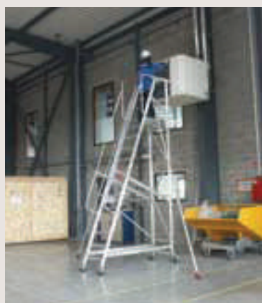
Stabilisateurs télescopiques en aluminium rabattables
